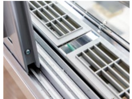
Laufschiene der Schiebetür und Luftführungsgitter
